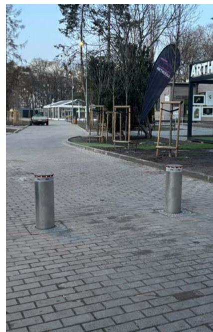
Słupki hydrauliczne Spartacus. Dom Kultury Arthouse, Warszawa.
